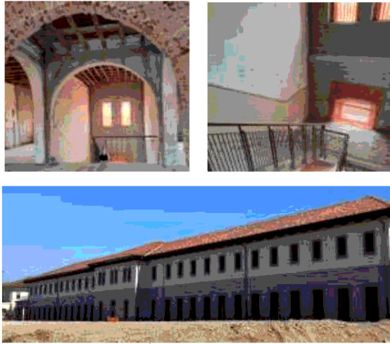
L'edificio, ancora al grezzo, che ospiterà gli uffici regionali
