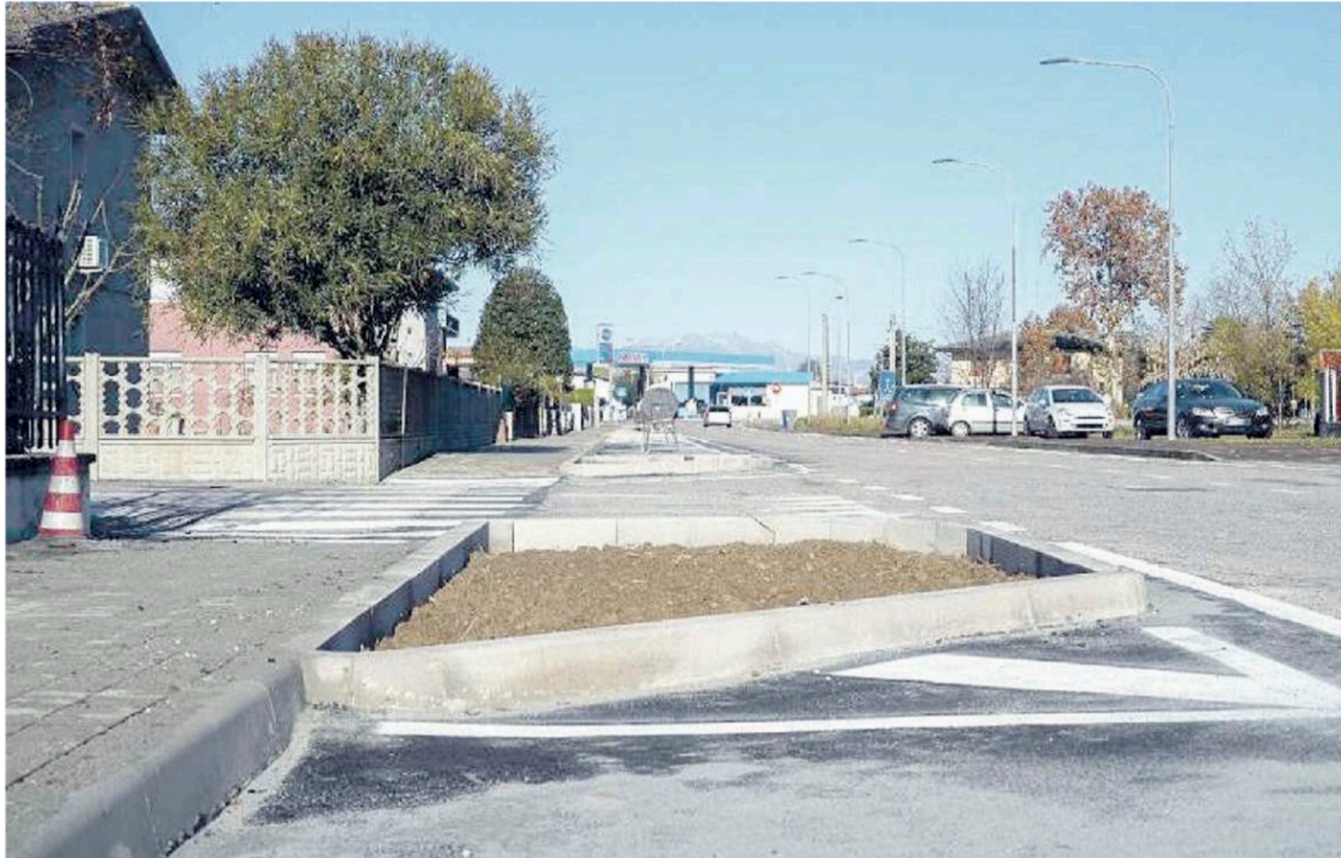
BIVIO TRIESTINA Via Salvo D'Acquisto, dove sono stati ricavati nuovi stalli per la sosta grazie ai lavori programmati dal Comune
