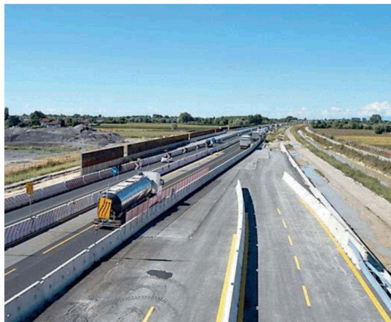
Lavori per la terza corsia dell'autostrada A4
